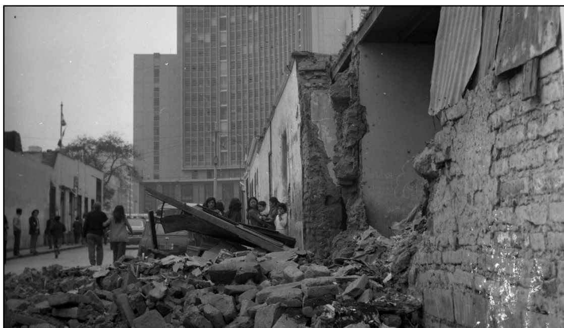
Figura N° 9. Destrucción causada por el sismo de 1974
